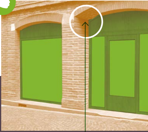
Devanture en recul du nu de la façade pour faire apparaître le tableau de la baie
