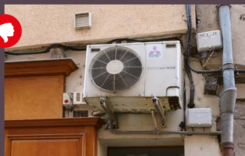
Machinerie apparente sur façade
