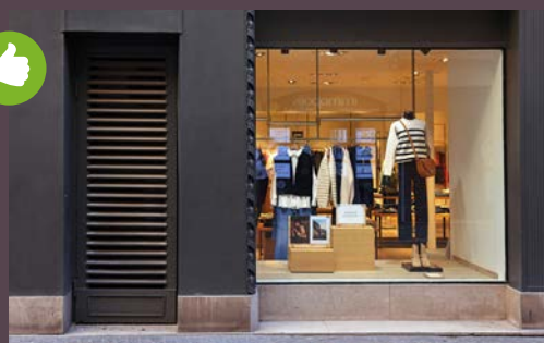
Appareillage intégré à la composition de façade
