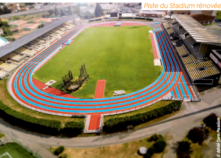
Piste du Stadium rénovée
