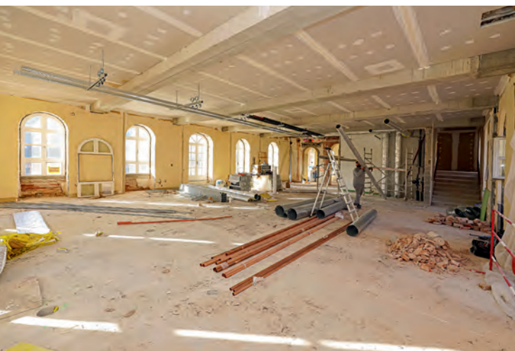
Le futur bar du Mercure en travaux.
