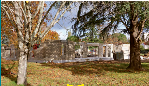
Cantepau, Construction de la nouvelle halte-garderie de la Négrouillère.
