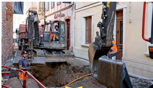
Rue de la Souque, réhabilitation de la rue et reprise des réseaux.
