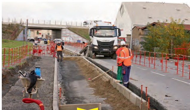
Route de Fauch, travaux de réfection de voirie.
