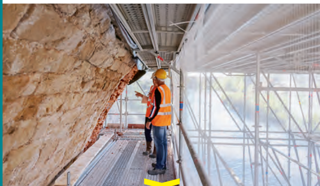
Pont-Vieux, poursuite de la restauration de l'ouvrage.
