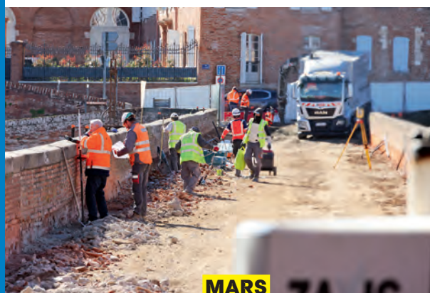
Début des travaux de restauration du Pont-Vieux.
