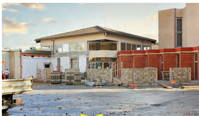
Cantepau, chantier de rénovation et d'extension de la Maison de quartier.
