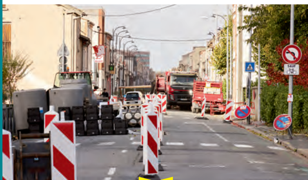
Avenue Colonel Teyssier, réaménagement de la voirie entre le rond-point de Gesse et le Stadium.
