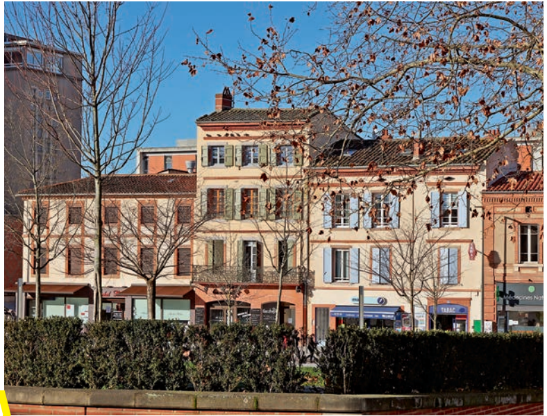
Une attention particulière est apportée aux façades visibles de la rue.
