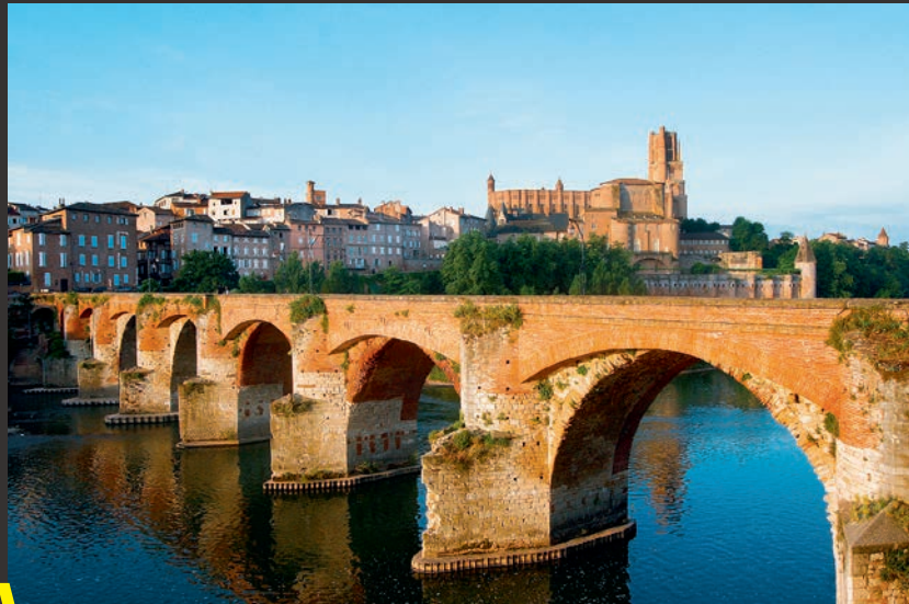
D'une longueur totale de 151,44 mètres, le Pont-Vieux se compose aujourd'hui sept arches.
