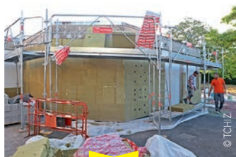
Rénovation énergétique des bâtiments de l'école Édouard Herriot.
