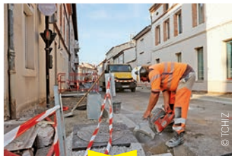
Requalification des trottoirs et de la chaussée rue de Bitche.
