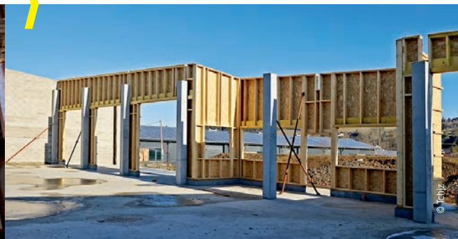
Maison de quartier de Ranteil en chantier.
