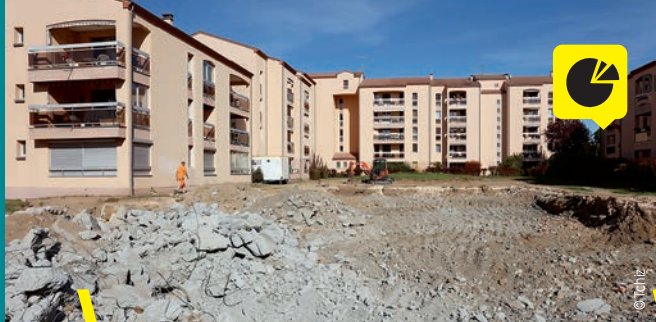
Jardin Charles d'Aragon en cours de travaux.
