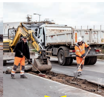
Rue du Roc Réfection de la rue.
