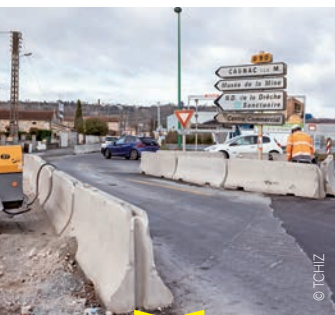
Route de la Drèche Extension du réseau d'eau et réfection de la rue.
