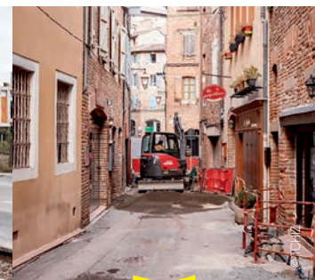
Rue Toulouse-Lautrec Requalification de la rue avec renouvellement des conduites d'assainissement et d'eau potable.
