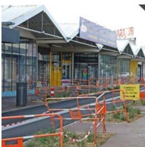
Rafraîchissement de la voirie à la zone commerciale de La Baute
