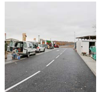
Voirie entièrement refaite à la déchetterie de Ranteil
