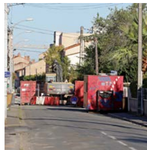
Poursuite de la réfection de la rue de Jarlard à Albi
