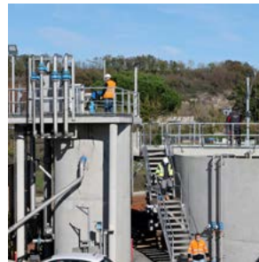
Une nouvelle station d'épuration voit le jour à Marssac-sur-Tarn
